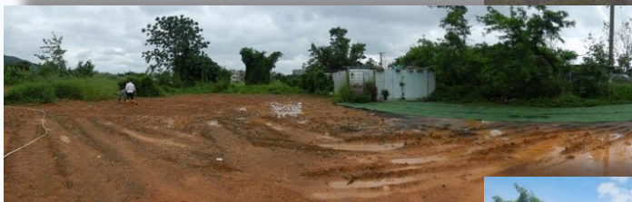
移除硬鋪地面
