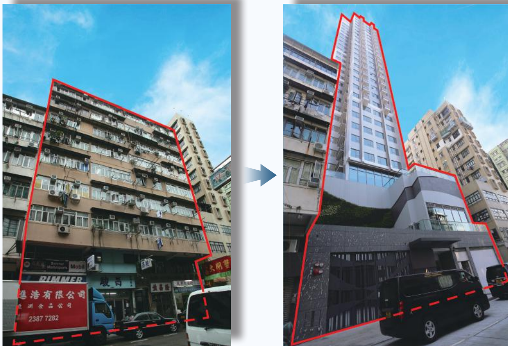
海壇街 229A 至 G 號需求主導重建項目 (DL-1:SSP) - 重建前及重建後
