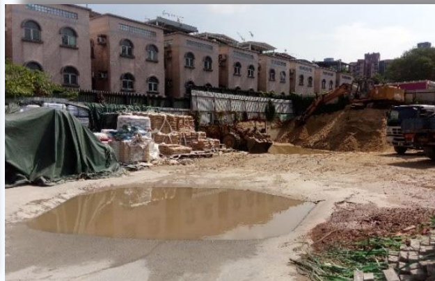
在住宅發展附近露天存放的大量建築材料
