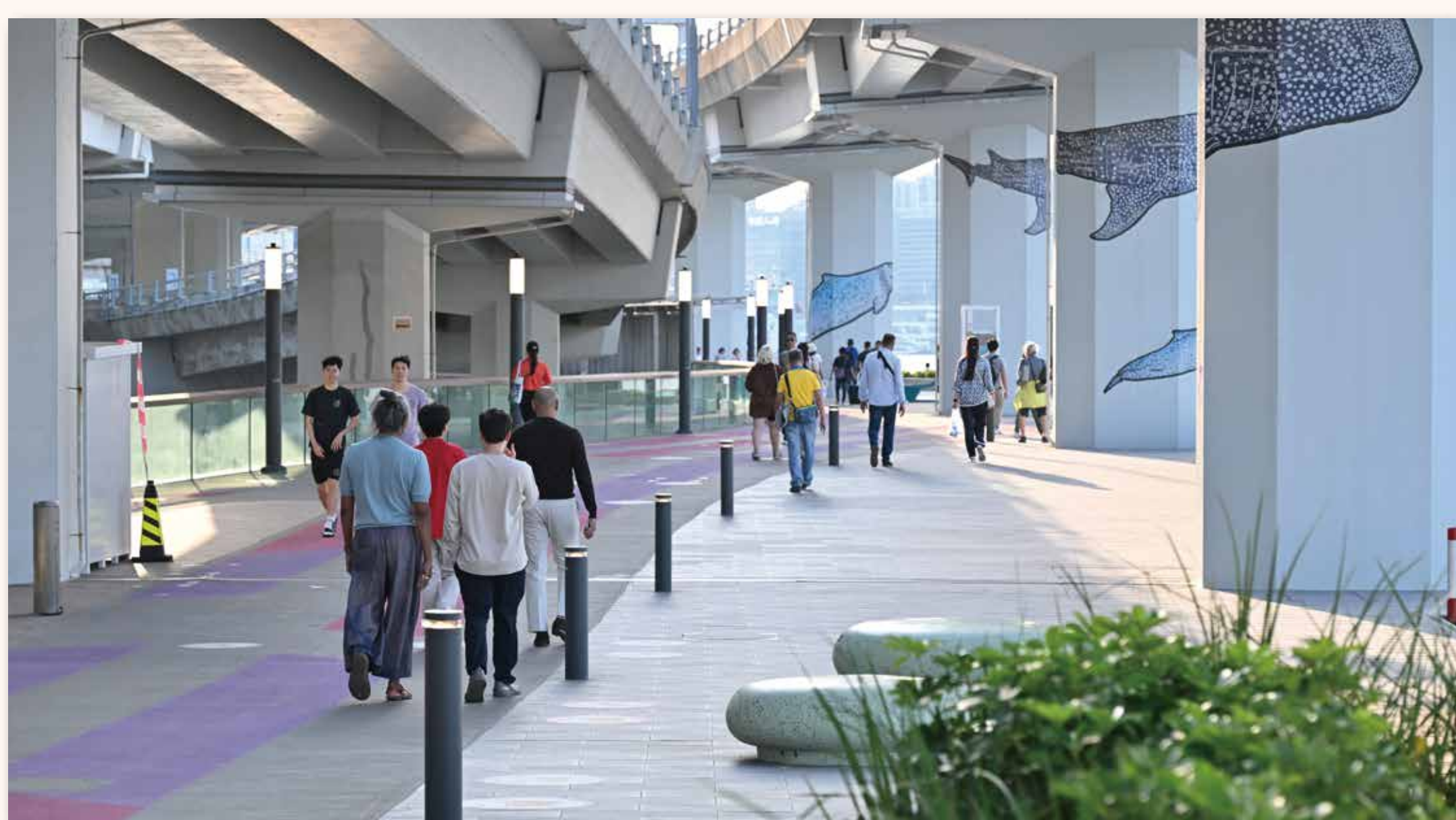
改造缺乏吸引力的空间 Transform Unattractive Spaces
