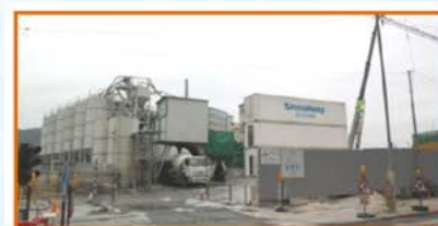
水泥廠 Cement Works
