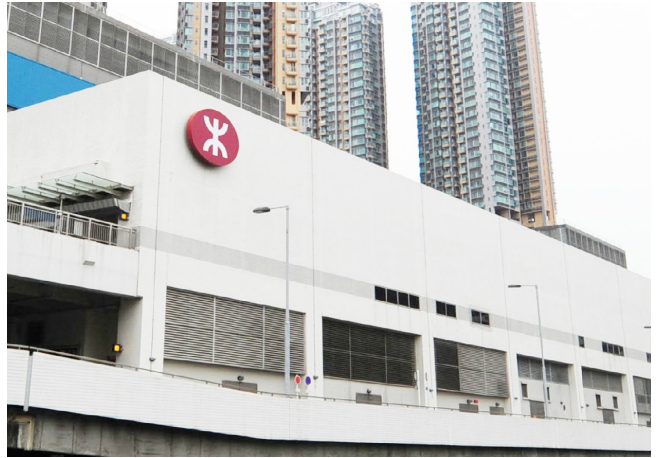
圖 4：屯馬線屯門站
