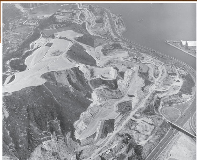
图 3：在葵涌附近群山进行开山挖土，以作填海之用
